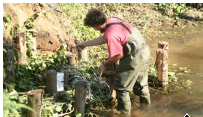
Mise en place d'un déflecteur.
